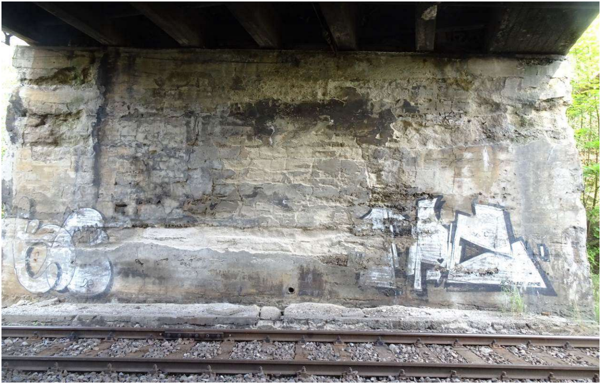
Rys. 1. Widok północno-zachodniego przyczółku od czoła
