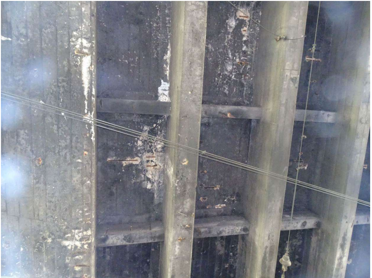
Rys. 1. Widok dźwigarów głównych (z poszerzonym dźwigarem północno-wschodnim z prawej)
