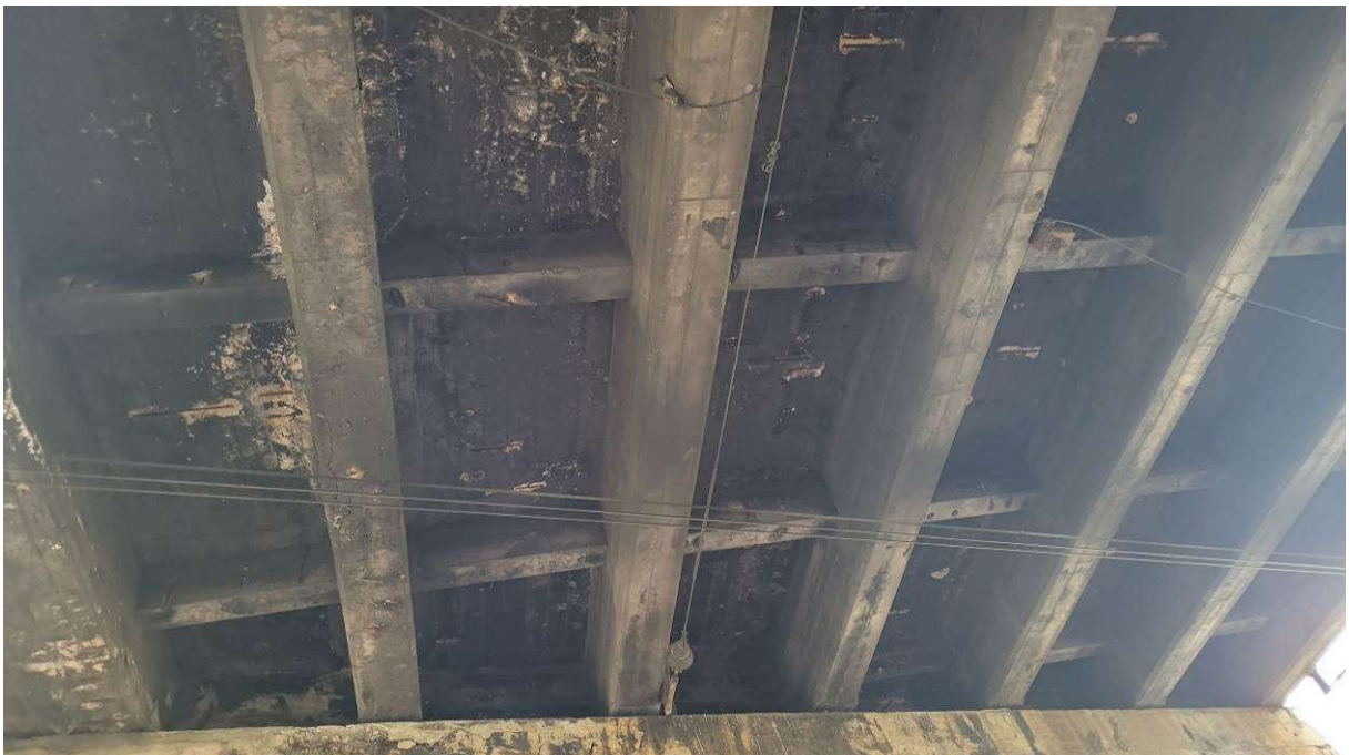
Rys. 1. Widok dźwigarów głównych
