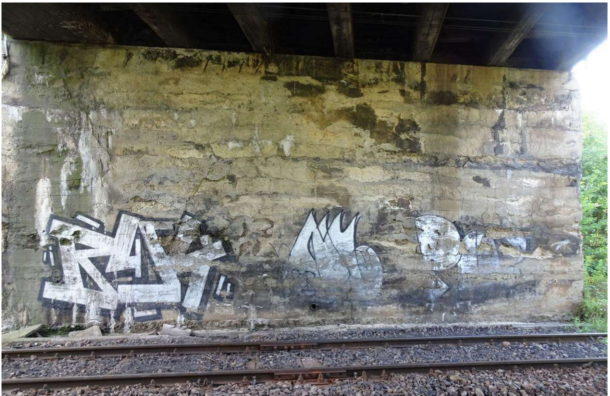
Rys. 1. Widok południowo-wschodniego przyczółku od czoła
