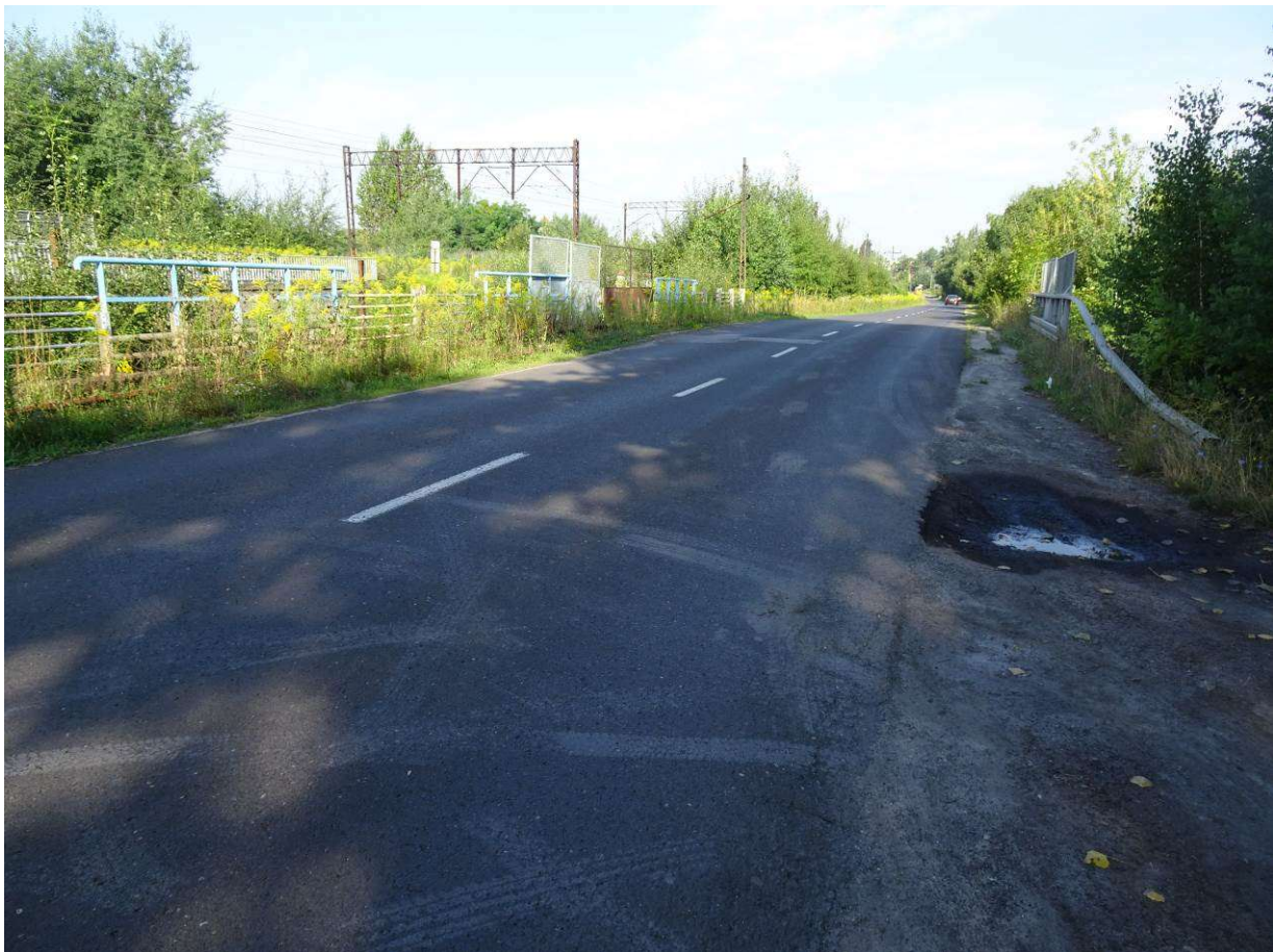
Rys. 1. Widok wiaduku od góry (od strony południowo-wschodniej)
