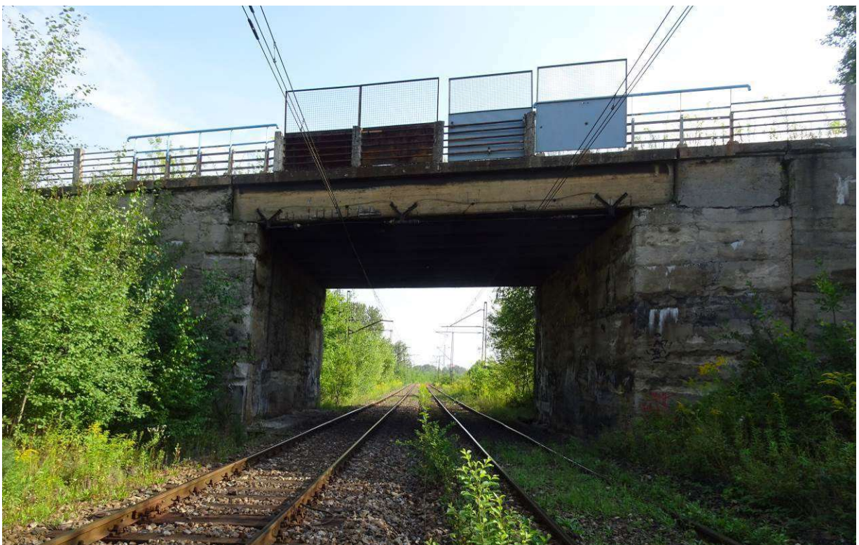
Rys. 1. Widok mostu od strony południowo-zachodniej
