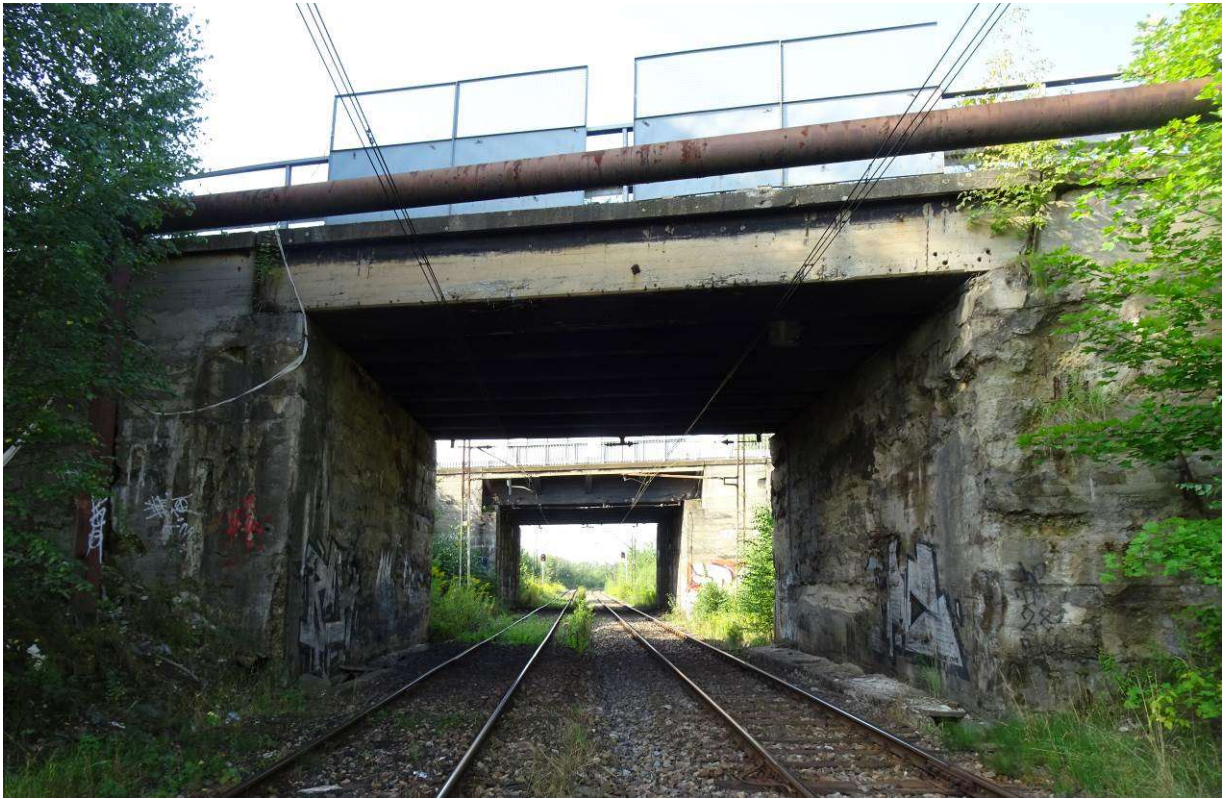
Rys. 1. Widok wiaduku od strony północno-wschodniej (przedmiotowy most na pierwszym planie)
