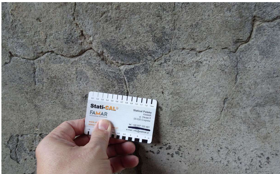
Rys. 1. Badanie wskaźnikiem rozwarcia rys. Przyciótek północno-zachodni. Rozwarcie 0,8 mm
